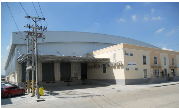
Entrée du site Delfingen
